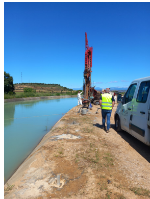
Trabajos de inyección
