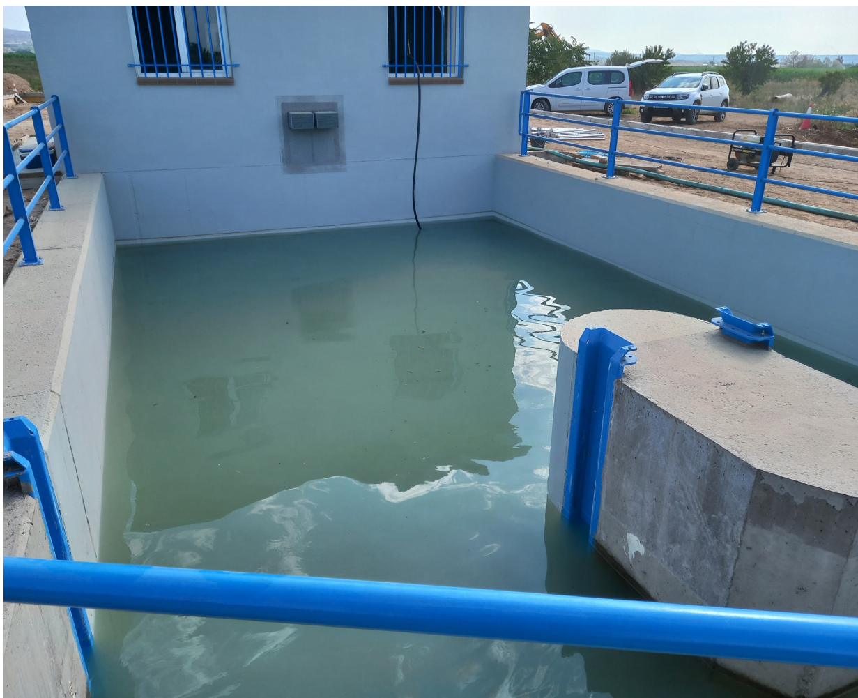
Obra de regulación de la Tubería de la Mola
